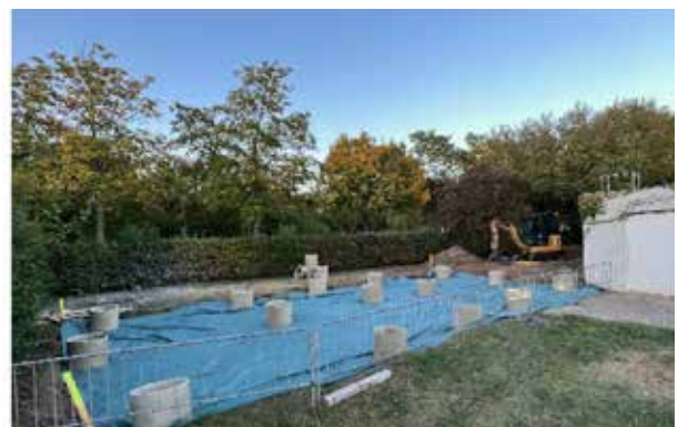
Bilder vom ersten Arbeitseinsatz am 13./14.10.23 im Grütstadium. Dabei waren das TuS-Bauteam und Helfer der Leichtathletikabteilung.
